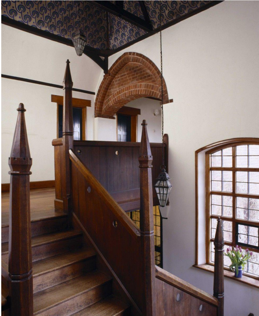
De eikenhouten trap in Red House. De puntige standers van de trap en de spitsboog van rode stenen op de overloop verwijzen naar de gotiek.
