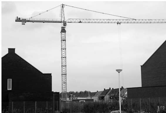
de complete bouwkraan
