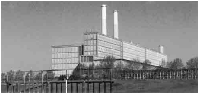
1 elektriciteitscentrale in Harculo
